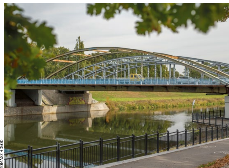
W 2014 r. wyremontowano most na nitce w kierunku Warszawy
